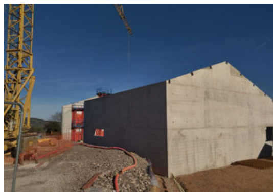
Début des travaux
