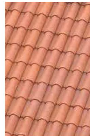
Toiture de tuiles romanes
